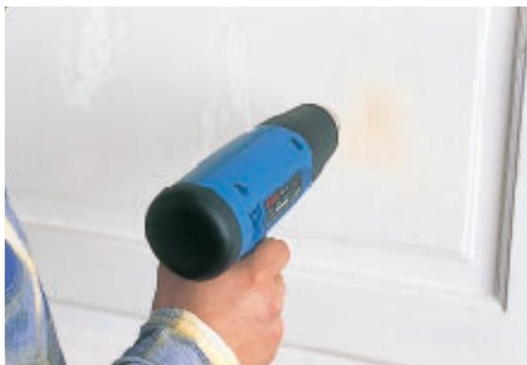
**1. Le pistolet décapeur à air chaud ressemble à un sèche-cheveux qui fournirait un air beaucoup plus chaud. Maintenir le pistolet à une dizaine de centimètres de la surface, pointé sur celle-ci.**
