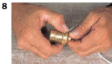
3. Desserrer les vis des bornes du noyau.
